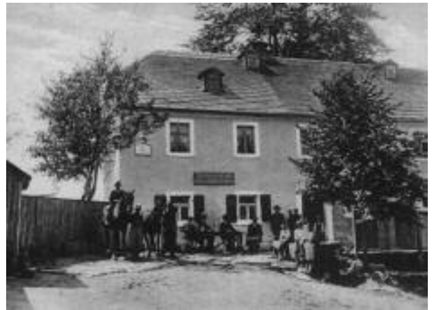
Ehem. Gasthaus Heerdegen
